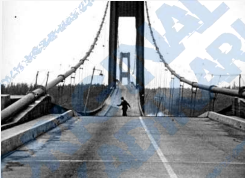
Contoh resonansi yang terjadi pada jembatan : The Tacoma Narrows Bridge (Jembatan Tacoma), Washington, USA.
